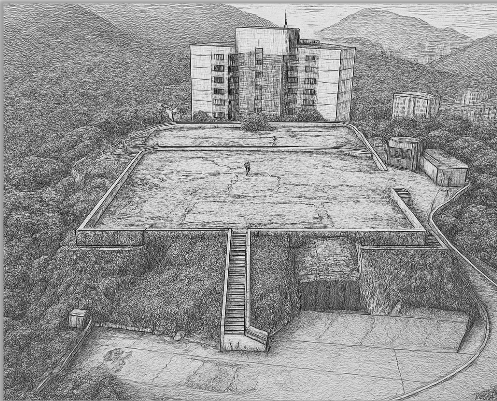
上圖：金馬倫山的北面 為忠靈塔基座的西北偏北方正面 這處原來應設有寬闊的梯級 現改為小樓梯 圖片來源：延陵科學綜合室
